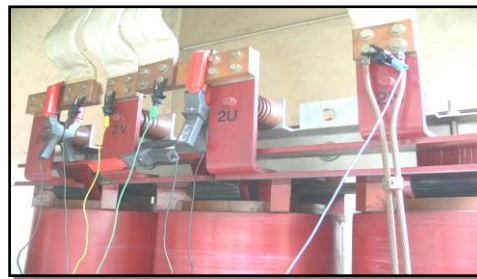
Gambar 2. Pemasangan klem kabel pada busbar transformator
