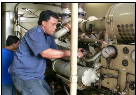
Gambar 1. Penggantian komponen gasket
