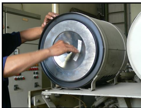
Gambar 2. Penggantian filter udara
