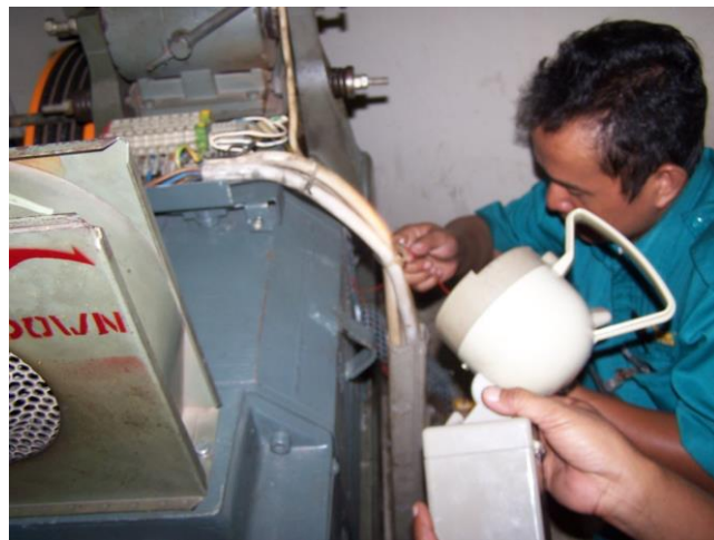
Gambar 8 Pemasangan thermis tambahan pada gulungan motor
